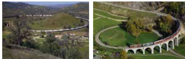
Петля сделана для того, чтобы поезд мог плавно «набрать высоту». Рельеф не позволил сделать это по-другому. При сильном наклоне локомотив не вытянет за собой вагоны.
